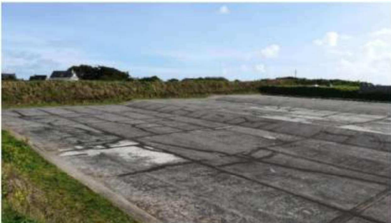
Figure 90 : Zoom sur la dalle béton de l'impluvium (source : TENERGIE)
