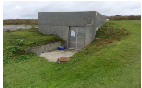
Figure 107 : Unité de production d'eau potable de l'île de Molène – station de traitement des eaux (source : DCI Environnement, décembre 2020)
