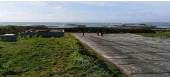
A gauche le local technique et à droite la dalle béton de collecte d'eau pluviale
