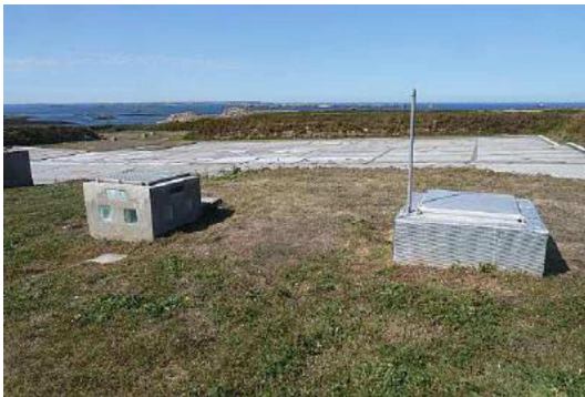
Figure 106 : Citerne au niveau de l'impluvium (source : https://www.patrimoine-iroise.fr/culturel/civil/eau-molene.php )
